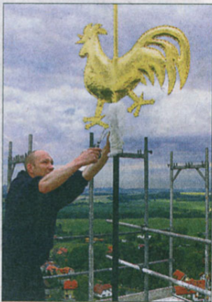
Spenglermeister Falk Schlieter installiert den Wetterhahn auf der Stolpener Kirche.
